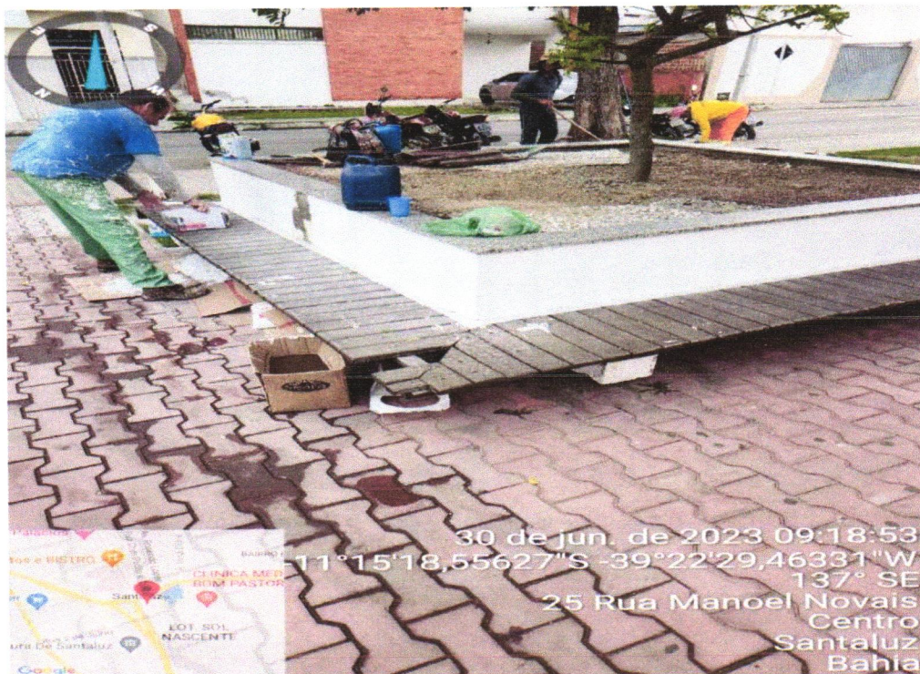
FOTO 08 - EMASSAMENTO DE PAREDES DO CANTEIRO.
