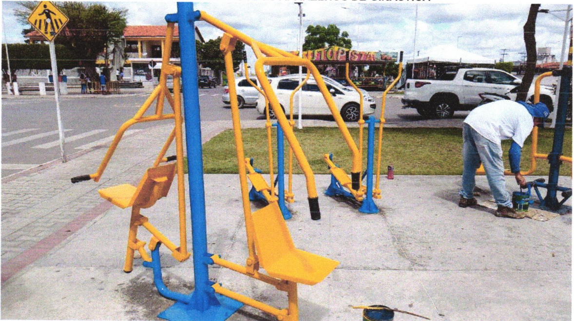
FOTO 20 - PINTURA DOS APARELHOS DE GINÁSTICA
