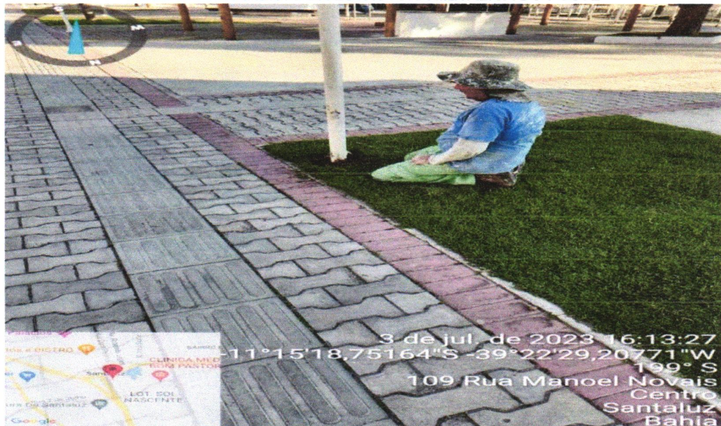
FOTO 13 – LIXAMENTO DA ESTRUTURA METÁLICA DO POSTE
