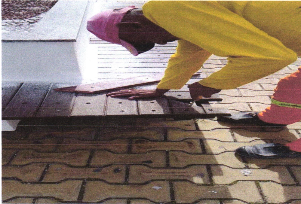
FOTO 10 - REPARAÇÃO DOS BANCOS DE MADEIRA
