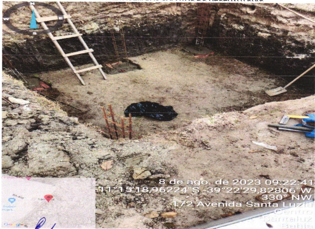
FOTO 28- CONCRETAGEM DAS SAPATAS DO RESERVATÓRIO
