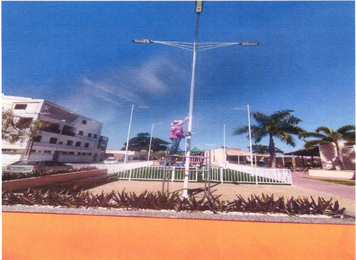
FOTO 33- PINTURA DO POSTE
