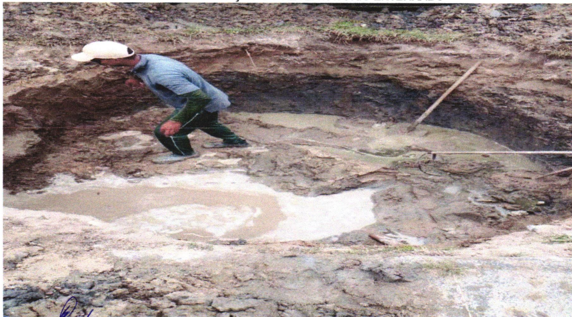
FOTO 26- ESCAVAÇÃO DO RESERVATÓRIO ENTERRADO
