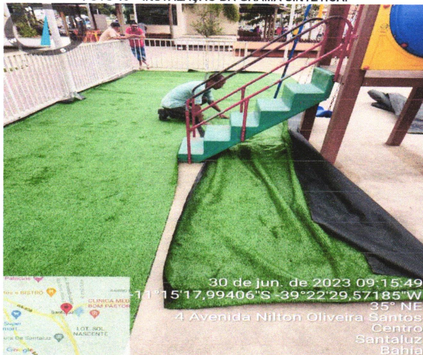
FOTO 18 – INSTALAÇÃO DA GRAMA SINTÉTICA.
