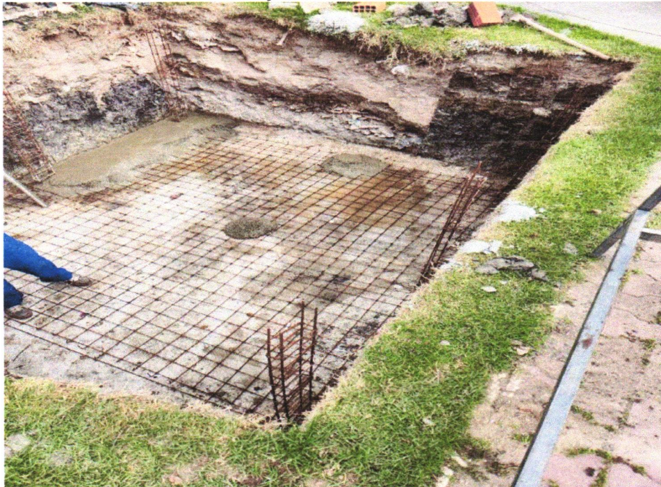
FOTO 36- EXECUÇÃO DO SEGUNDO RESERVATÓRIO
