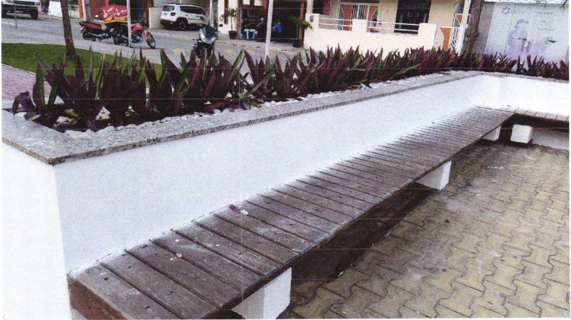
FOTO 05 – EMASSAMENTO DE PAREDES DO CANTEIRO.
