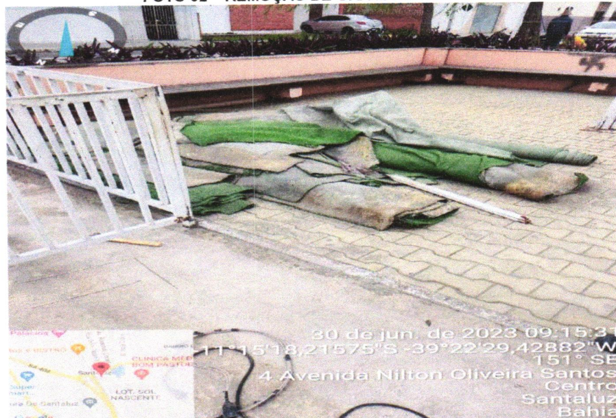
FOTO 02 – REMOÇÃO DE GRAMA SINTÉTICA
