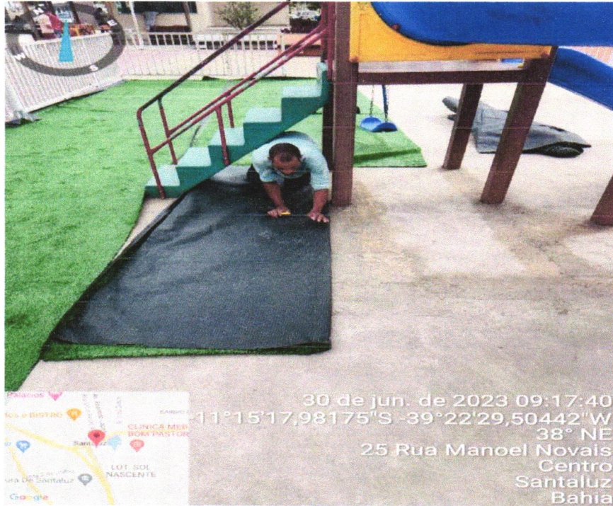
FOTO 17 – INSTALAÇÃO DA GRMA SINTÉTICA.
